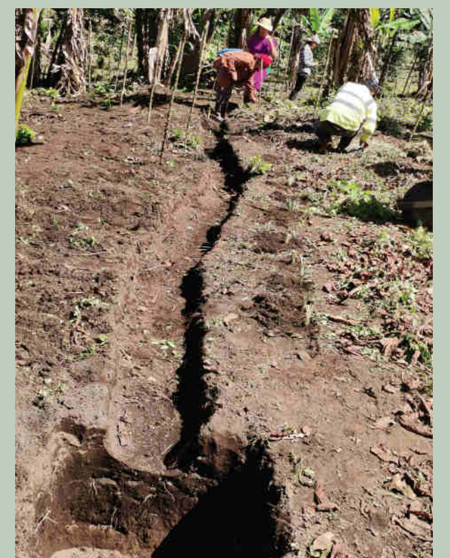
Construcción de acequias o zanjas a nivel.
