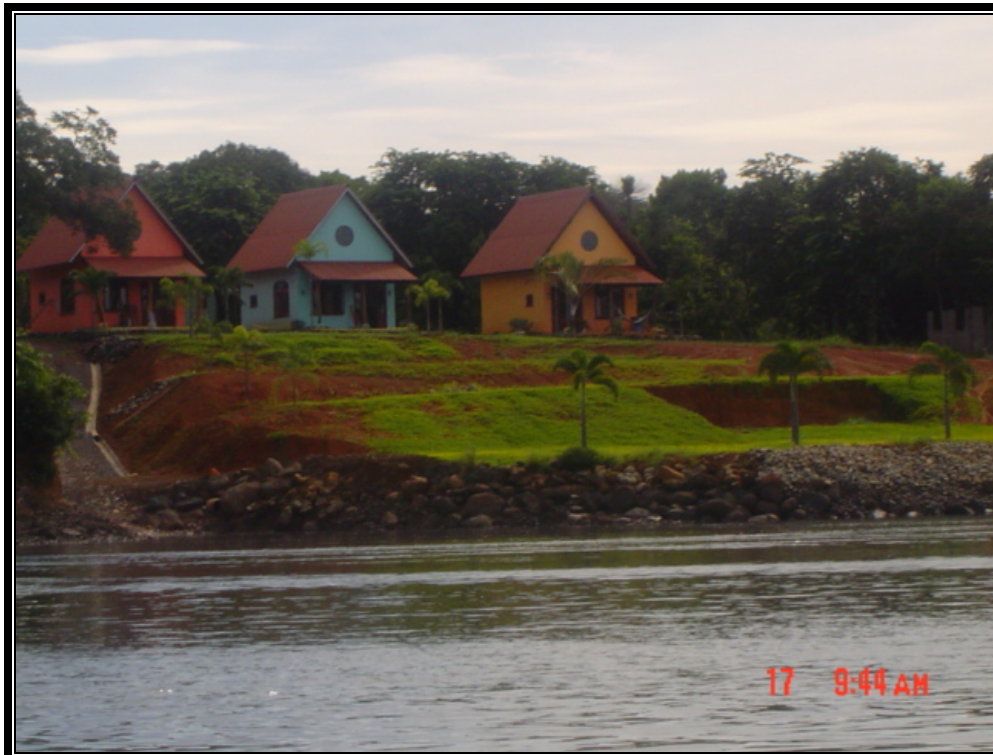
Figura 25 Construcciones de Villas turísticas, Boca Chica Golfo de Chiriquí
