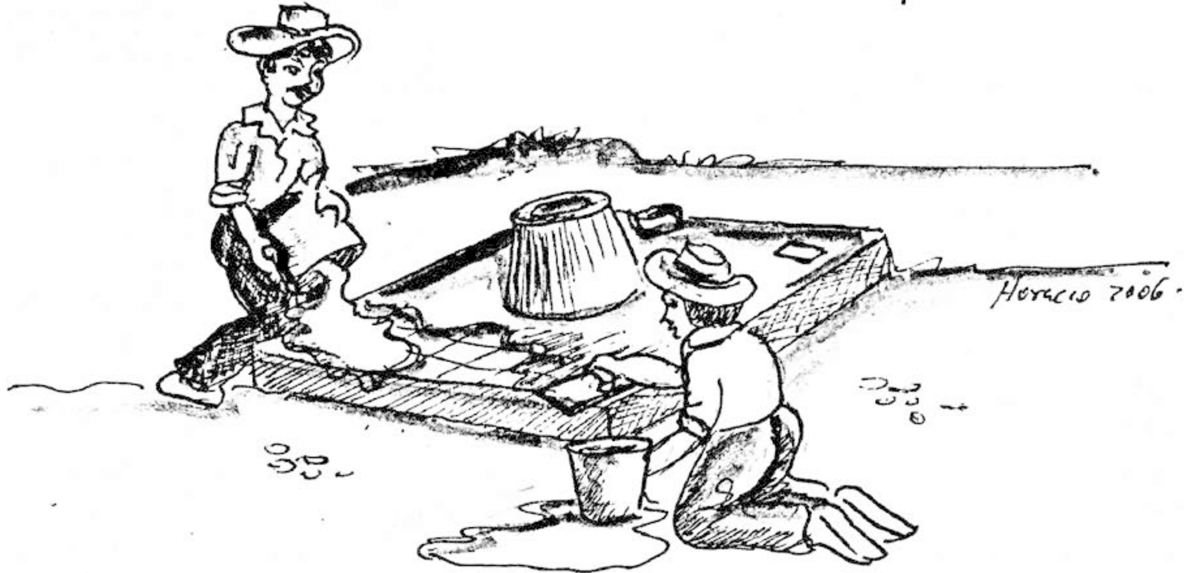
FIGURA No. 3.4 La losa o piso de la letrina debe tener la misma forma y tamaño de la base, colocando la taza en el centro.
