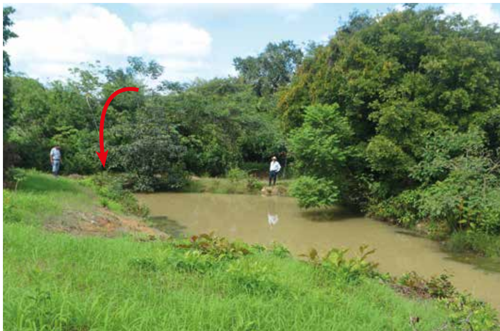
Reservorio en la finca de Juan de los Santos en Herrera. La flecha señala el lugar en el que se encuentra el tubo de desagüe que permite que el nivel del reservorio no alcance el borde superior del talud de contención.
