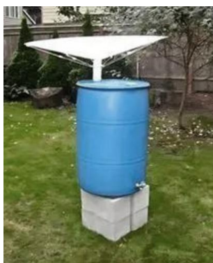
Figura 2. Sistema de cosecha de agua portátil utilizando un embudo de plástico o metal
