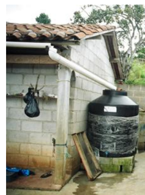
Figura 3. Sistema de cosecha de agua utilizando un techo en un área rural.
